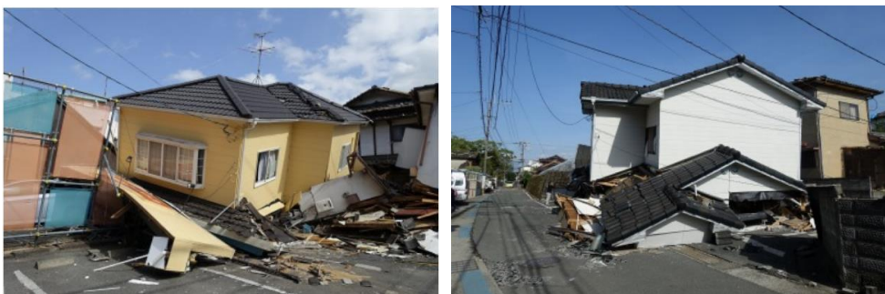
写真 熊本地震における倒壊した新耐震基準の木造住宅の状況
