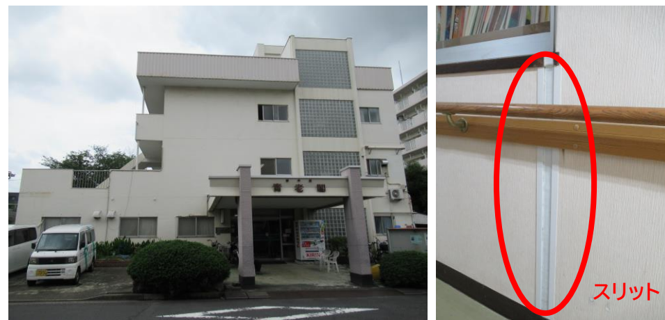
写真 養護老人ホームの耐震改修事例
