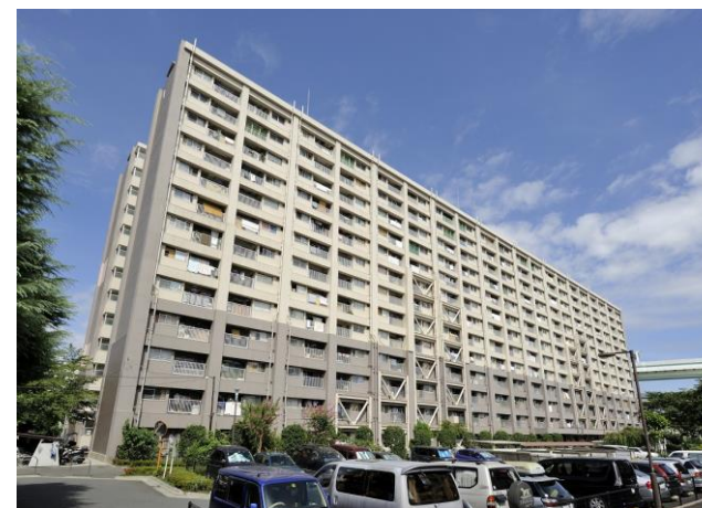
写真 東京都住宅供給公社の耐震改修事例(鉄骨ブレースの設置)
