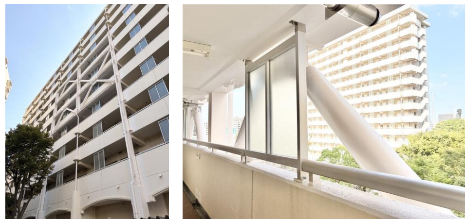
写真 マンションの耐震改修事例
