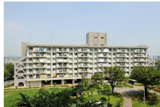
写真 東京都住宅供給公社の耐震改修事例(バットレスの設置)
