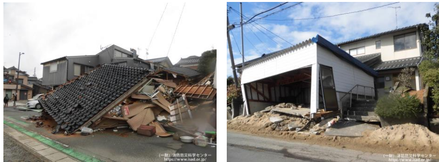
写真 令和6年能登半島地震における建築物被害 (出典:一般財団法人 消防科学総合センター)
