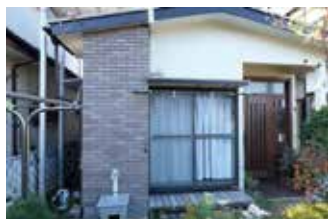
フレーム完成
