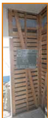
①既存壁の撤去
