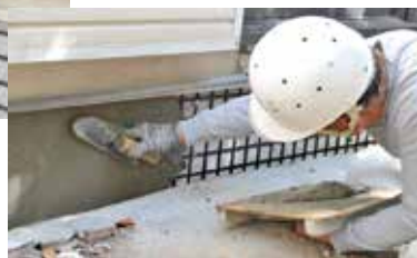
ERモルタル塗り込み
