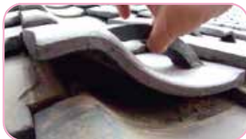
屋根瓦の葺き土の有無を調査
