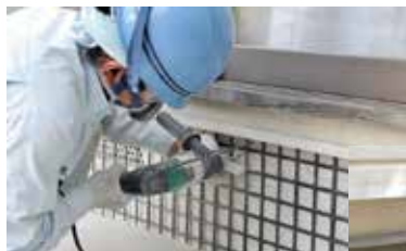
FRPグリッド設置
