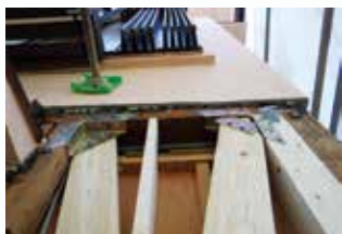
通し柱補強（室外より）
