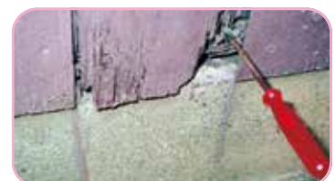
土台の腐朽度合いを調査
