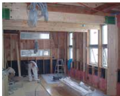
間仕切部の耐震補強
