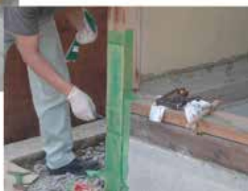
柱脚補強（ホルダウン15kN相当）
