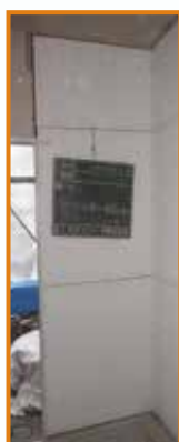
③パネルの施工
