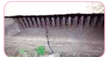
基礎のひび割れを調査
