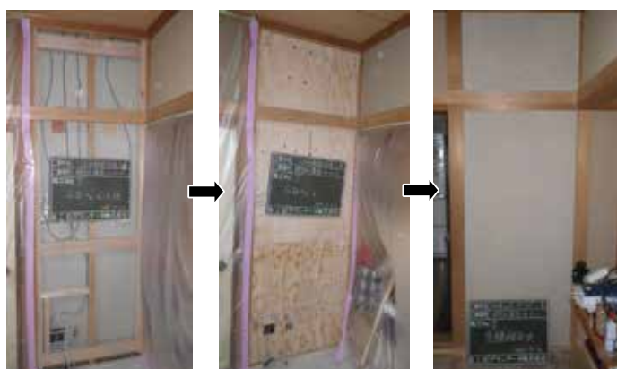
合板受材施工
