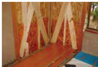
押入れ内補強
