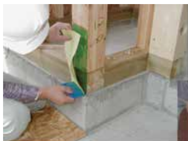
柱脚補強（ホルダウン10kN相当）
