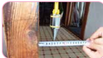
下げ振りで柱の傾きを調査
