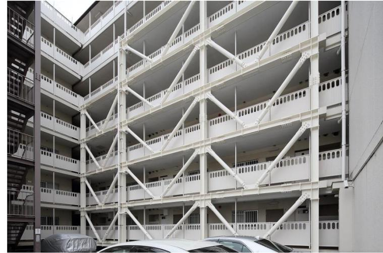
外廊下先端に制震ブレース設置 (制震工法)
