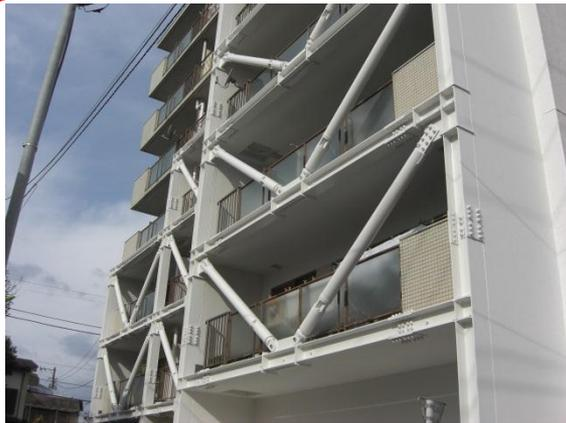
バルコニー先端に制震ブレース設置 (制震工法)
