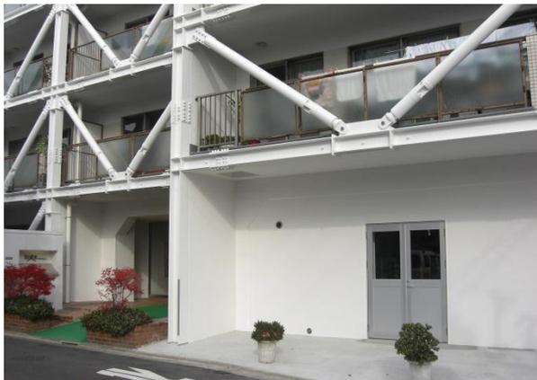
1階にRC耐震壁新設 (強度型補強)
