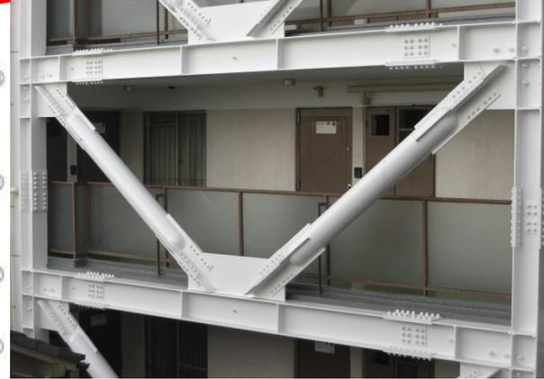
外廊下先端に鋼管ブレース設置 (強度型補強)
