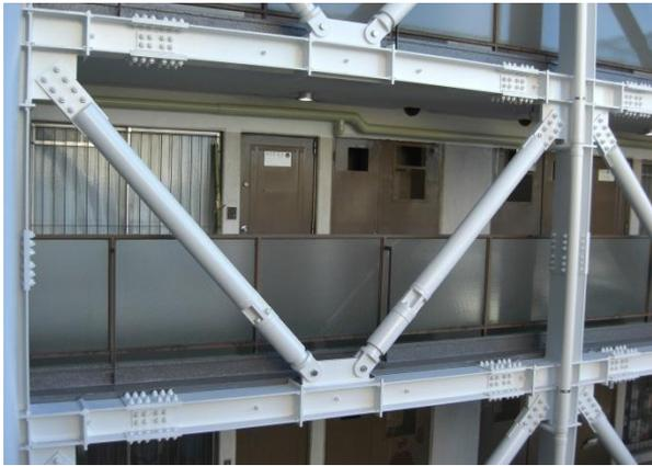
外廊下先端に制震ブレース設置 (制震工法)
