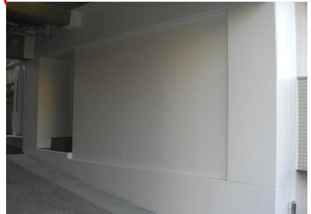
1階車路の柱・壁を増し打ち (強度型補強)
