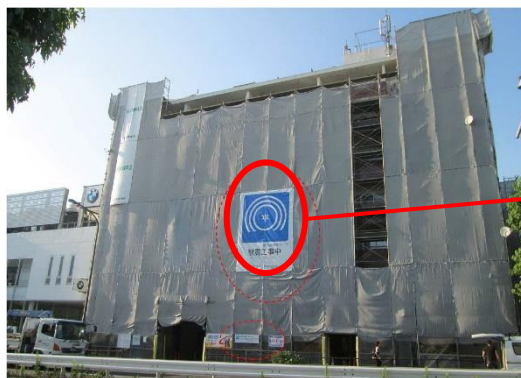
写真 工事現場掲示風景
