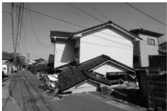
写真 熊本地震における倒壊した新耐震基準の木造住宅の状況
