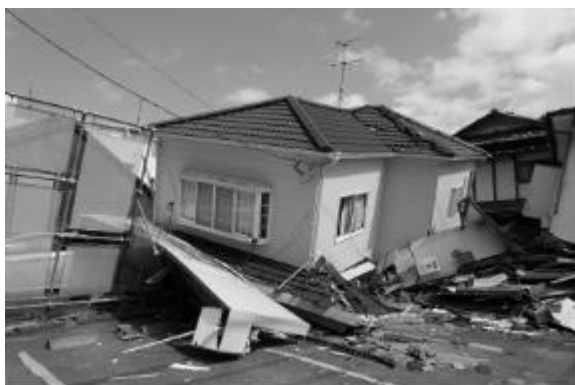
写真 熊本地震における倒壊した新耐震基準の木造住宅の状況
