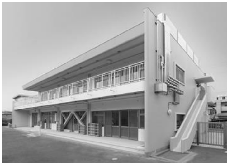
写真 保育所の耐震改修事例
