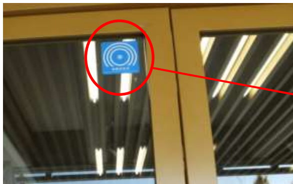
写真 耐震マーク掲示風景
