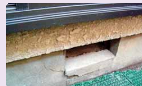
7 外部から外壁や基礎のひび割れ、地盤の沈下等の有無を確認します。
