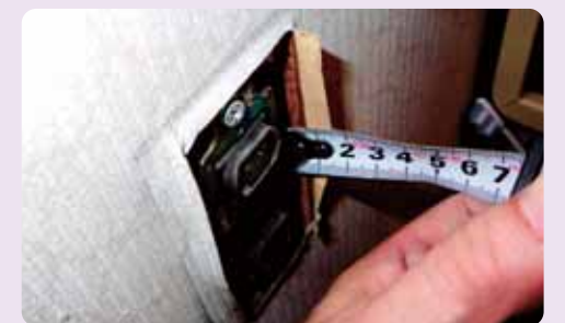
4 仕上げを壊さないようにコンセントカバーを外して、合板の厚みを確認します。
