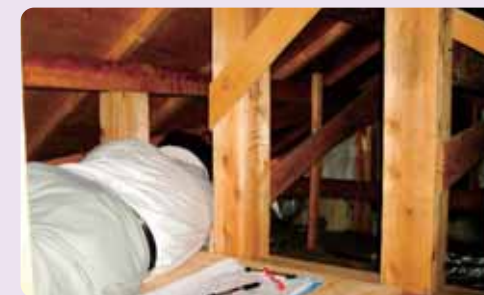
3 屋根裏から、壁内部の筋かい、合板の仕様、柱梁の接合部の仕様等を確認します。
