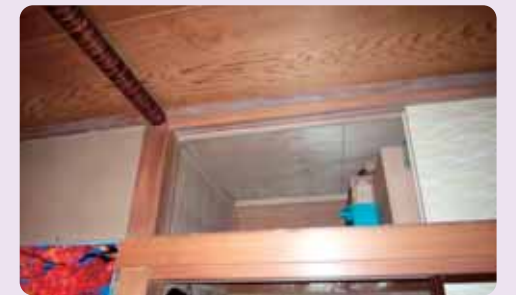
2 押し入れの天井を外して、屋根裏に入ります。
