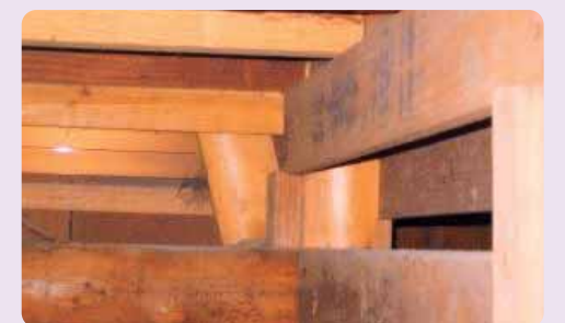
6 床下から壁内部の筋かい等の仕様の確認をするともに、腐朽箇所の有無を調べます。
