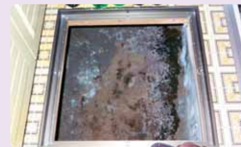
5 風呂場等の水廻り付近の床下点検口から床下に入ります。
