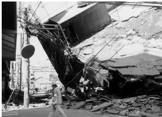
写真 阪神・淡路大震災における建築物の倒壊による道路閉塞の様子
