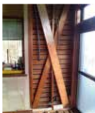
食堂内既存壁補強状況
