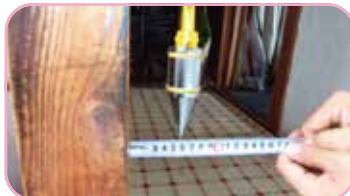
下げ振りで柱の傾きを調査
