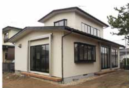
フレームプラス施工事例
