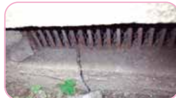
基礎のひび割れを調査
