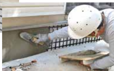
ERモルタル塗り込み
