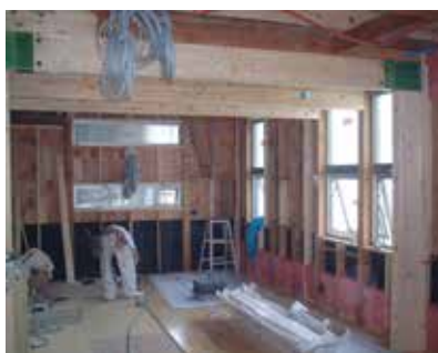
間仕切部の耐震補強
