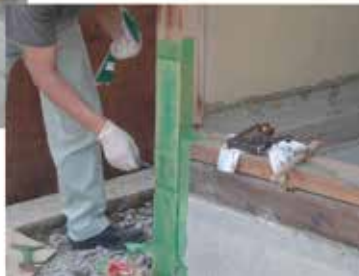
柱脚補強 (ホルダウ15kN相当)
