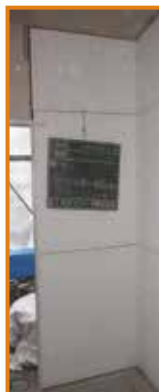
③パネルの施工
