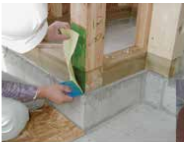
柱脚補強 (ホルダウ10kN相当)
