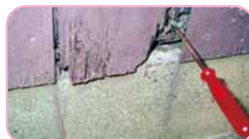
土台の腐朽度合いを調査
