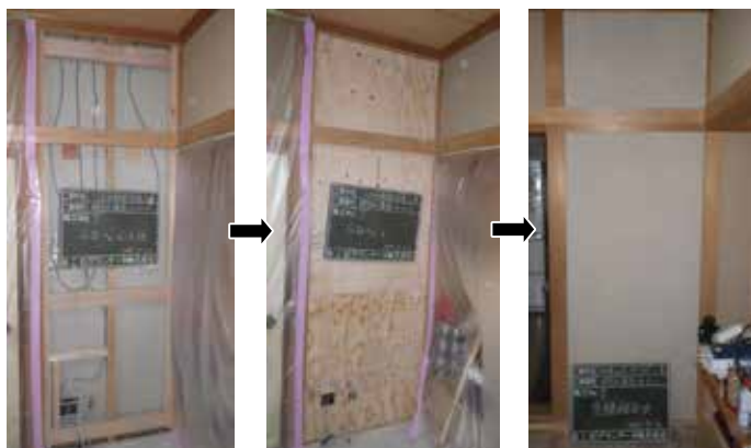
合板受材施工
