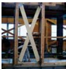
耐力壁加力試験風景
