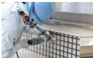
FRPグリッド設置
