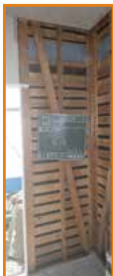
①既存壁の撤去
