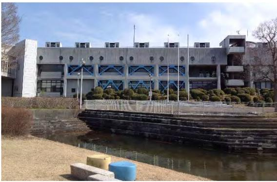
1 階多目的ホール、2 階研修室部は外側から鉄骨プレースを設置、3 階宿泊室部は内部に耐震壁を増設
