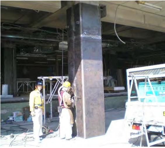
鋼板巻きによる柱のせん断補強
