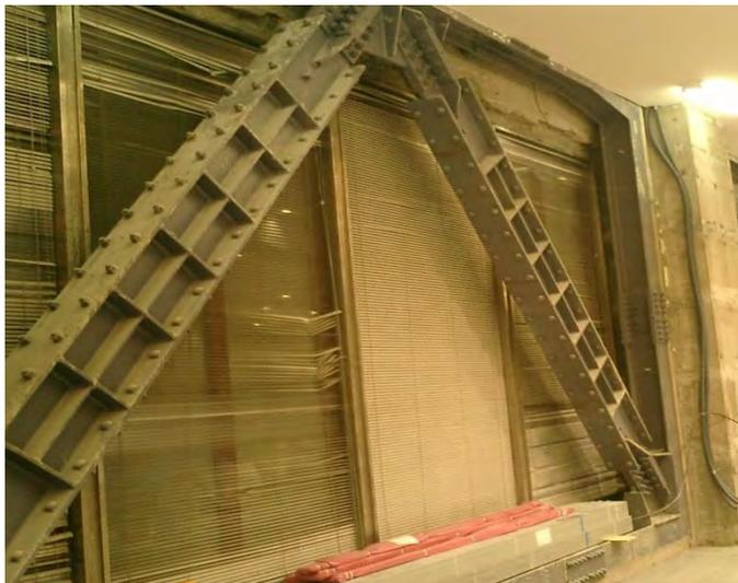
制震装置（エネルギー吸収型の履歴型鋼材ダンパー）
