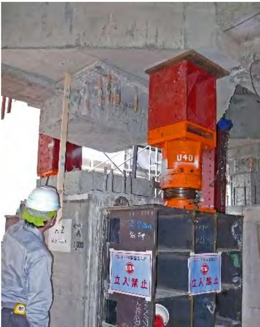
免震装置を設置するために柱頭部分を切断
