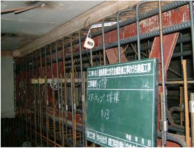
耐震壁増設・新設部周りの既存鉄骨梁は鉄骨鉄筋コンクリート造による補強
