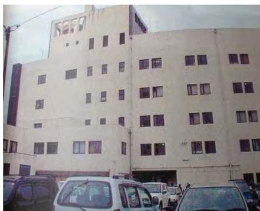
鋼板内蔵RCブレース補強した北側外観
