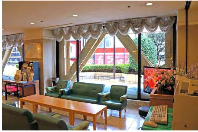
ロビーから見えるように設置した枠付き鉄骨ブレース
