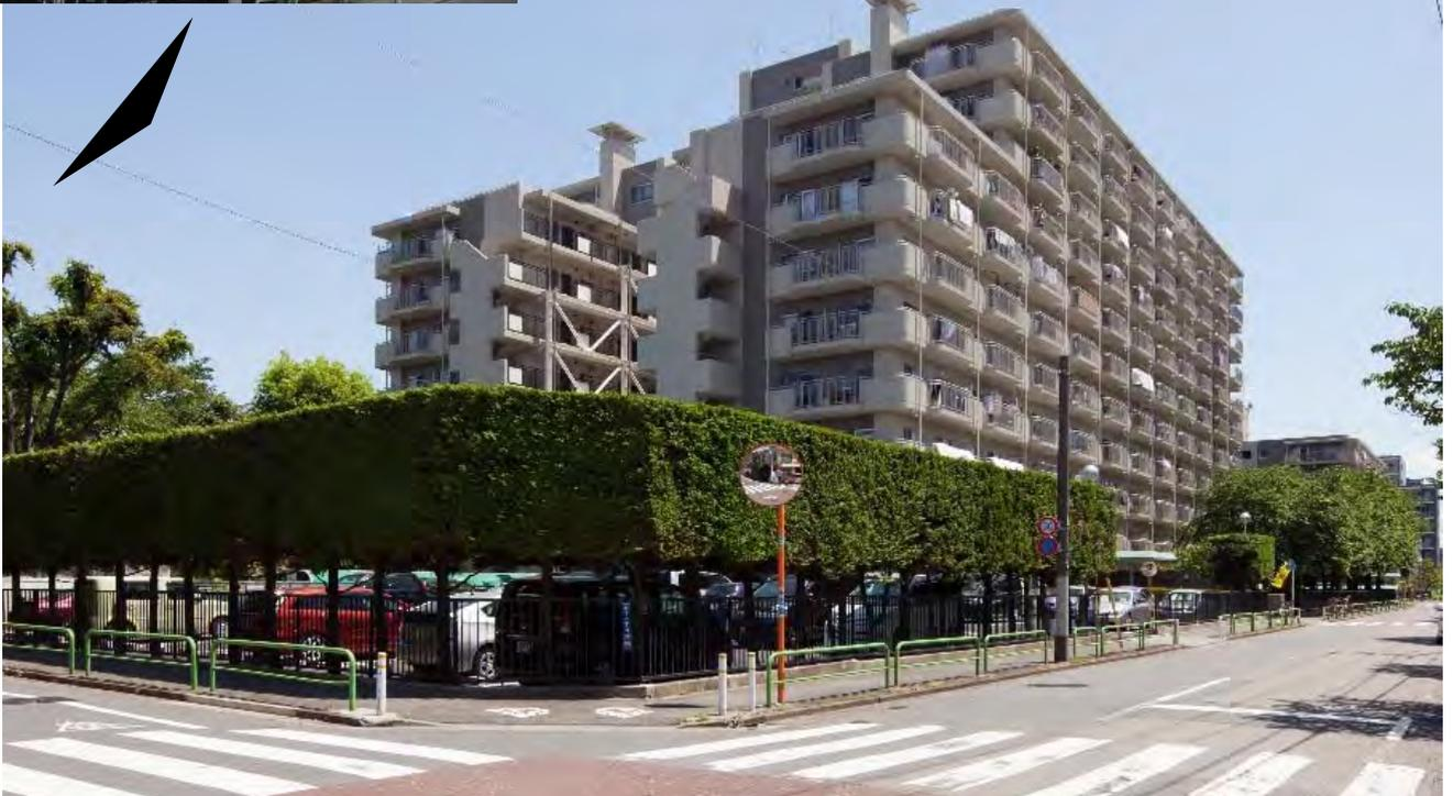
改修後 廊下側に外付制震ブレースを取り付けた1号棟
