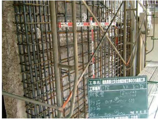
耐震壁増設部の配筋状況。増設部は既設壁と合わせて450mm、新設部は450mmの壁厚とした
