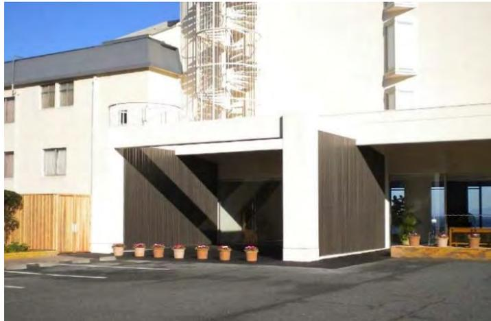
増設梁により玄関脇へ下屋新設（制震装置付）、ルーバーでデザイン
