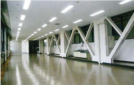
事務室内観 採光等の機能を損なわないプレース補強
