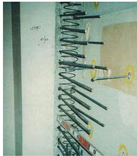
壁増し打ち部のアンカー筋及びスパイラル筋
