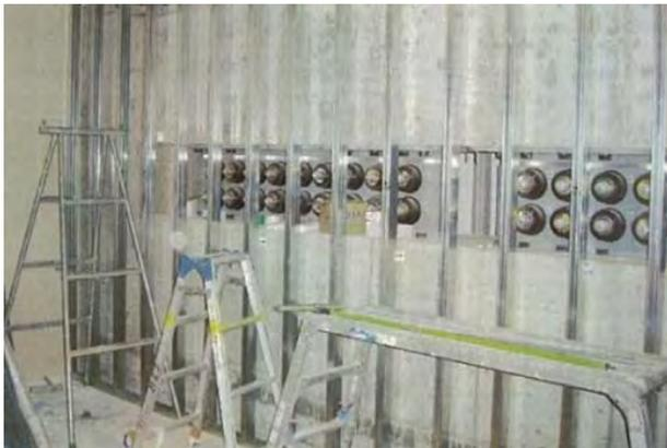
ブレーキ（制振）ダンパーにより耐震壁を設置
