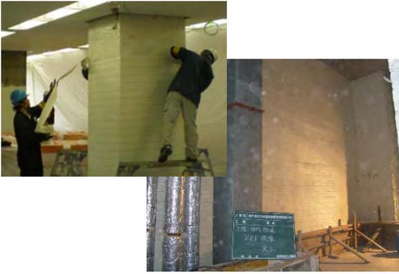
「壁補強にSRF工法採用」
