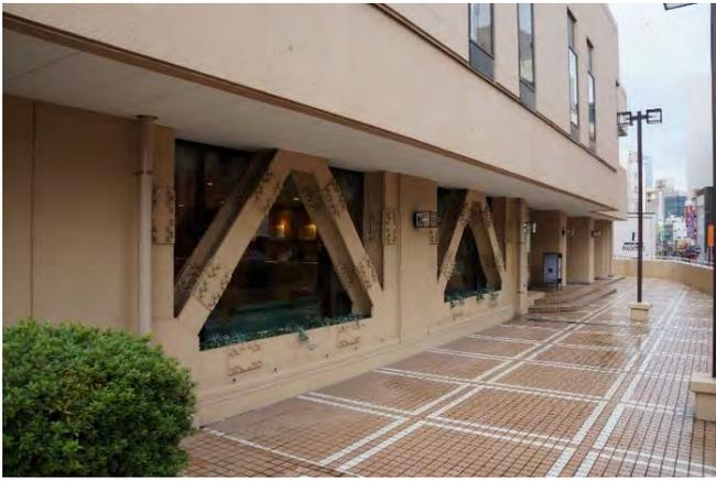
枠付き鉄骨ブレース（2階）により内外にアピール
