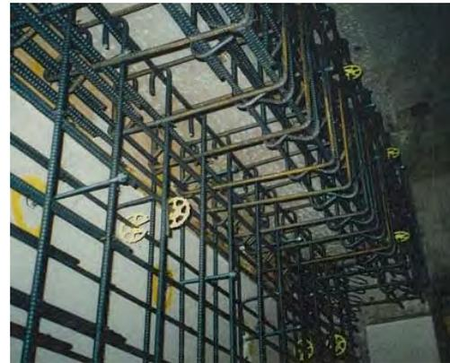
梁増し打ち部の梁巻き配筋
