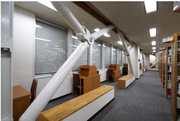
マンサード型鋼管ブレースによる空間活用（2F）
