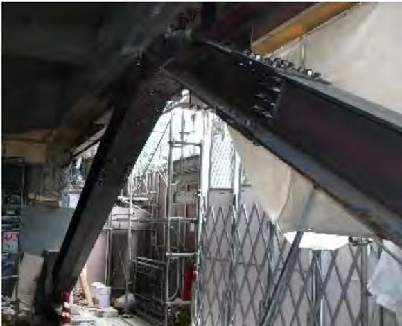
工事期間中の地震対策として仮設ブレースを設置
