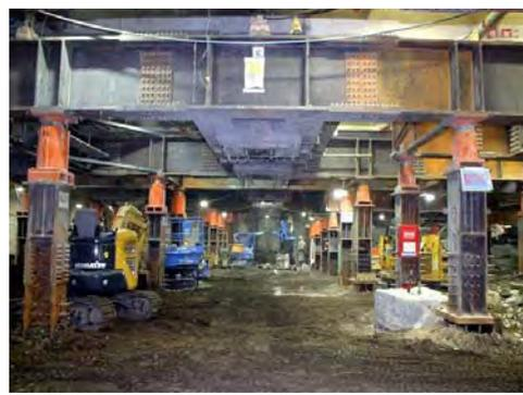
工事中（鉄骨フレームによる建物仮受）
