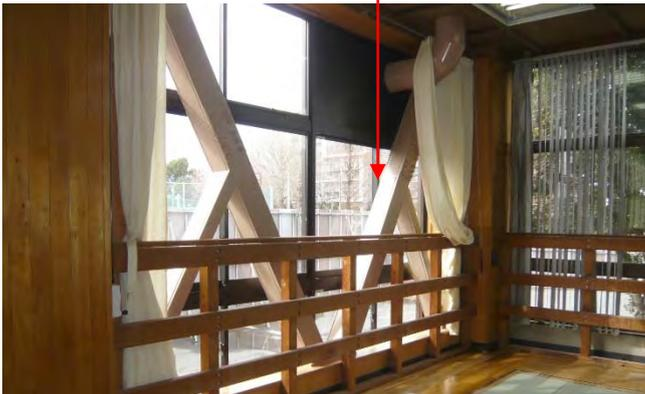
鉄骨ブレース設置 (1階剣道場)
