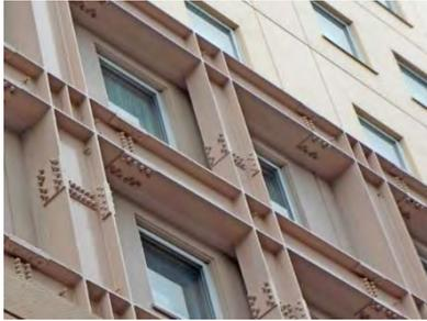
外壁面に設置した外付け鉄骨フレーム
