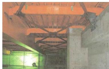
屋根：水平鉄骨ブレース
