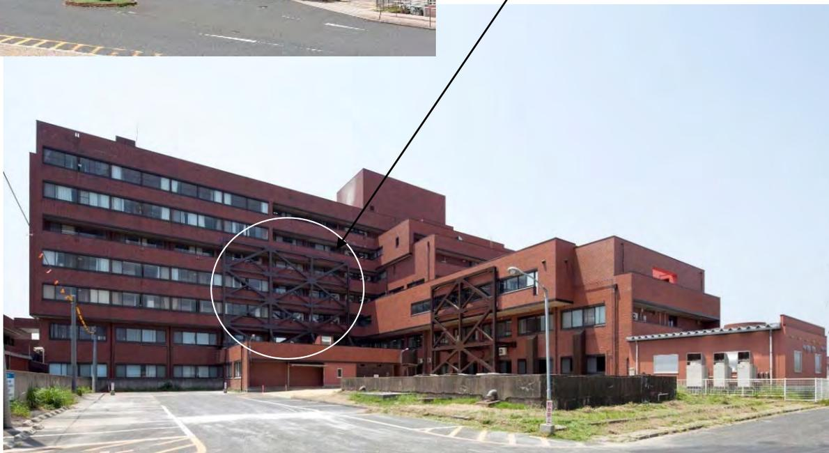
外付けフレームを中心にして、用途や機能、動線などに配慮して多様な耐震改修工法を採用
