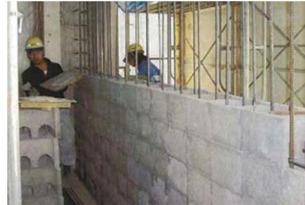
低振動・騒音、省スペース施工が可能な工法による耐震壁(高強度ブロック)
