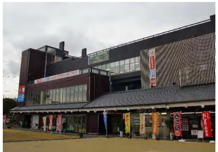
解体部分(写真手前)を広場として整備。切り取られた建物の断面を改修し、ファサードを一新
