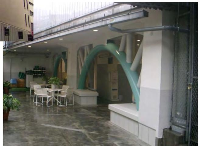
テナントの営業に支障をきたさず、意匠にも配慮した円形型鋼管ブレース
