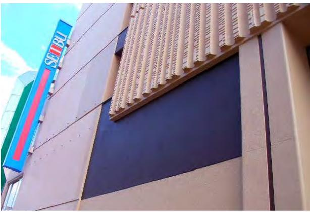
2階無開口増設壁と柱補強
