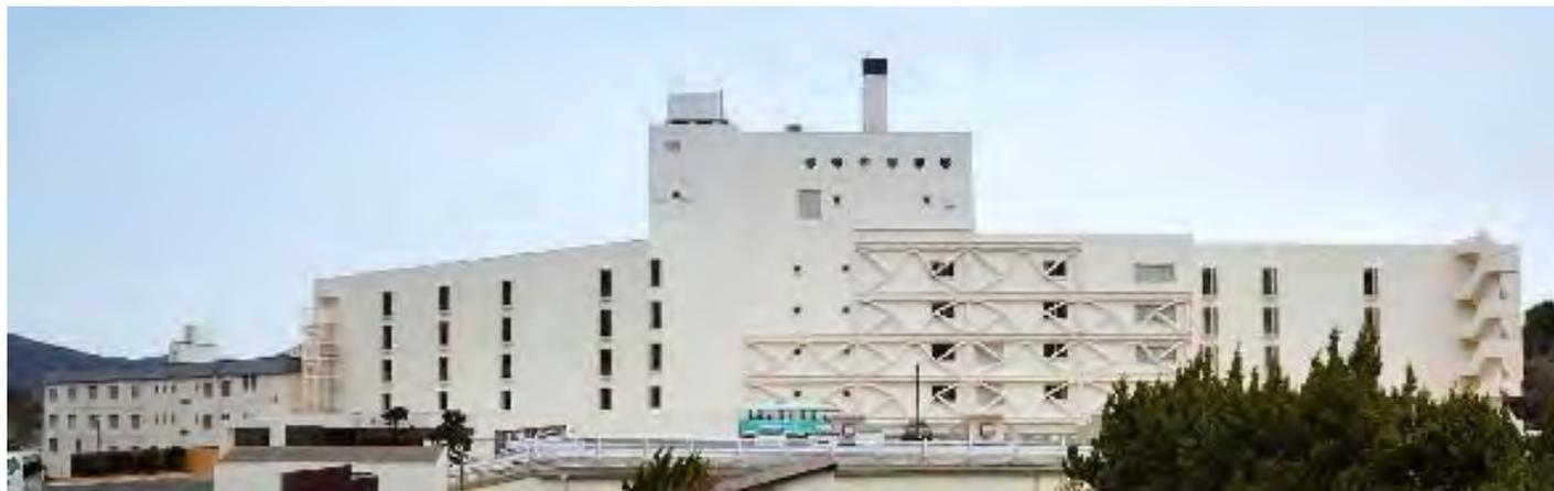
客室から海への眺望を阻害しないよう、主として建物の山側外壁に制震装置を設置
