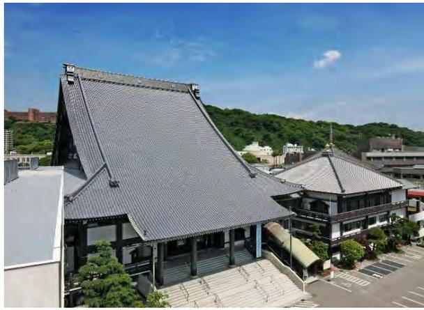
上部に重くのしかかっている陶器瓦をチタン瓦に葺替えることで軽量化
