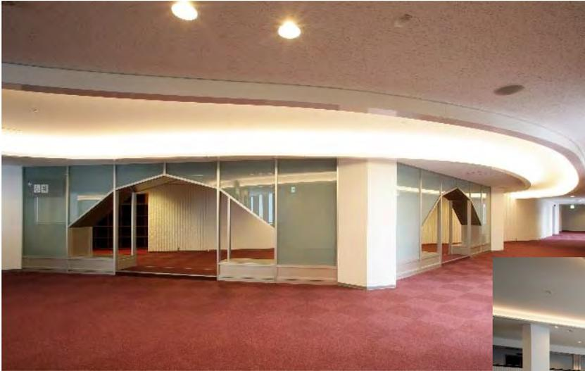
大ホールホワイエに面して通り抜けができるマンサード型耐震ブレース
