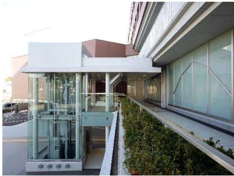
バリアフリー対策としてのエレベーター新設とマンサード型耐震ブレースを用いた意匠性の高い外観
