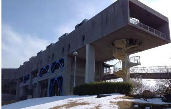
ピロティ部では柱鋼板巻補強を実施
