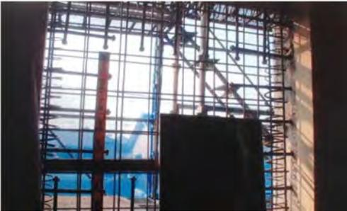
開口部を閉鎖する壁補強の施工状況
