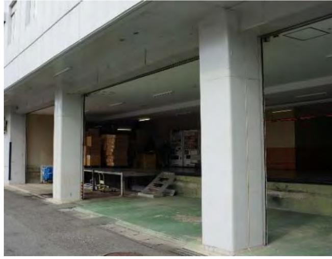
鋼板巻き立て補強により柱断面を大きくしないで、せん断強度を確保
