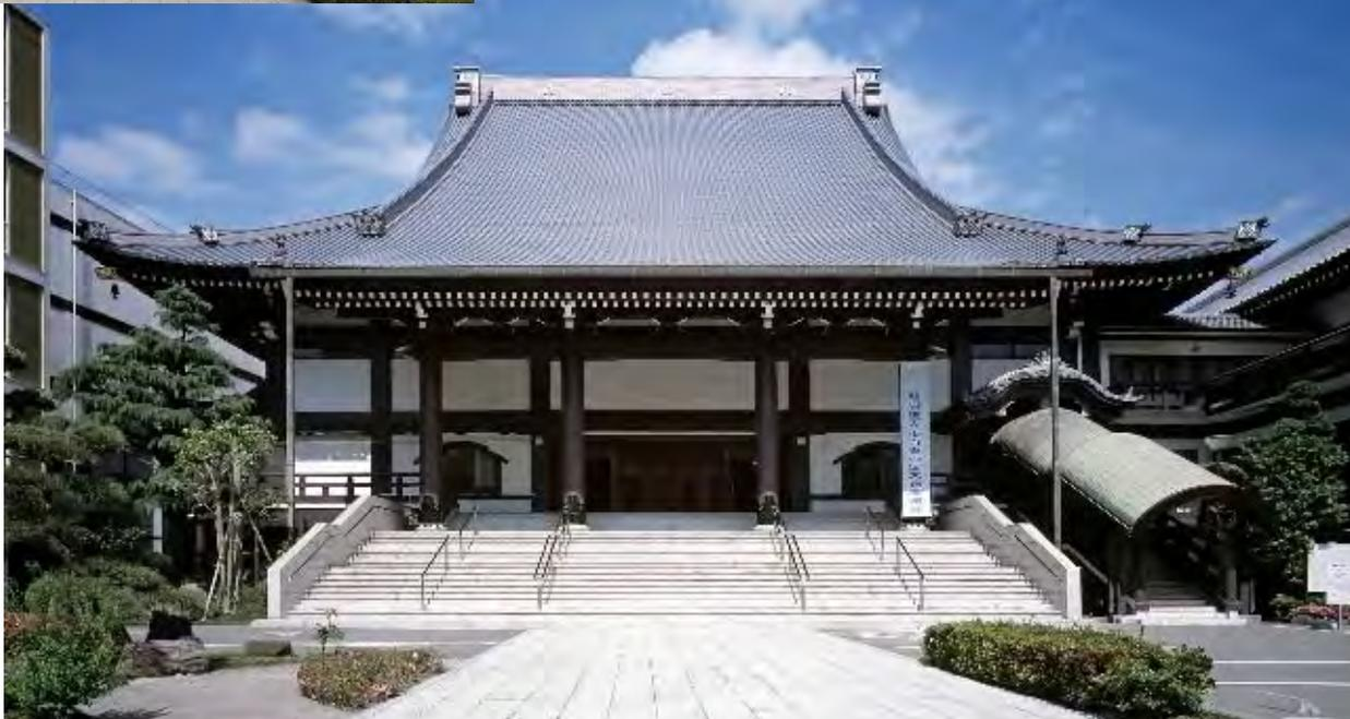
チタン瓦に葺き替え美しさと軽量化を実現した外観
