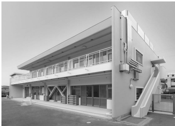
写真 保育所の耐震改修事例
