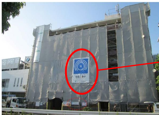
写真 工事現場掲示風景
