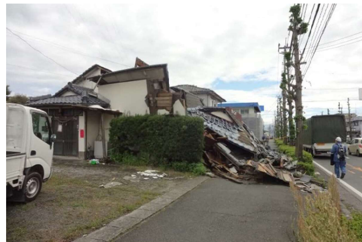
住宅が倒壊し、前面道路(歩道部分)を閉塞している
