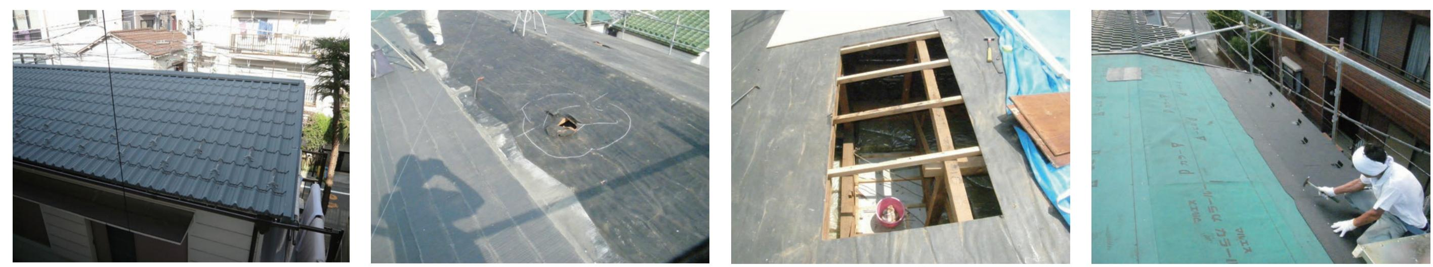
既存の瓦屋根 → 瓦屋根を撤去 → 破損部分の修復 → 既存屋根の補修
