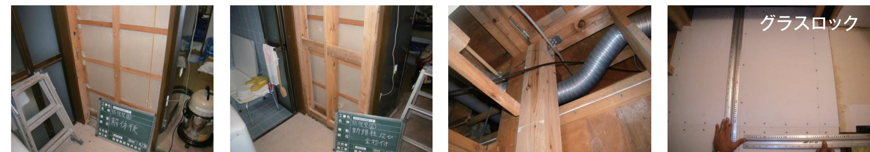
既存の壁を撤去 → 新規に柱を設置 → 接合部を金物で固定 → 耐力壁取り付け
