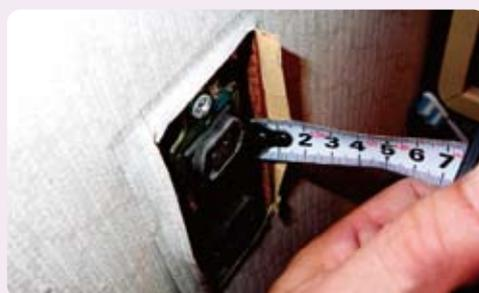
4 仕上げを壊さないようにコンセントカバーを外して、合板の厚みを確認します。
