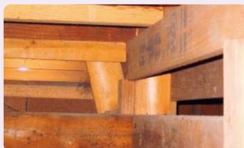
6 床下から壁内部の筋かい等の仕様の確認をするとともに、腐朽箇所の有無を調べます。
