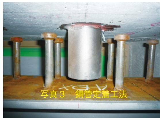
写真 3 鋼管定着工法
