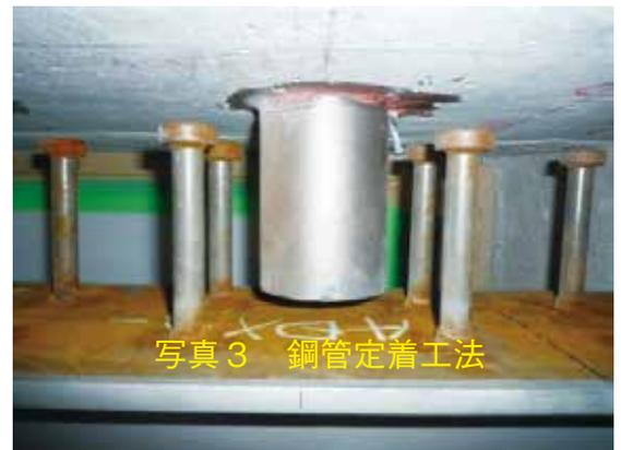
写真3 鋼管定着工法
