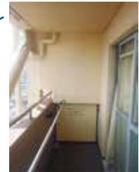
制震ブレースをバルコニー先端に設置。屋内工事回避
