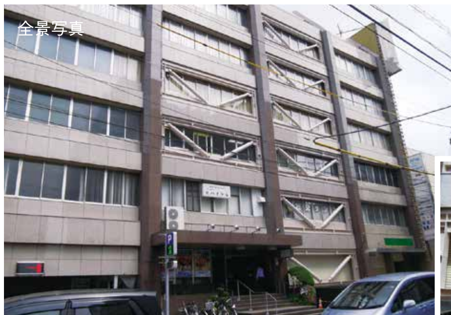
A D座屈拘束ブレース写真
