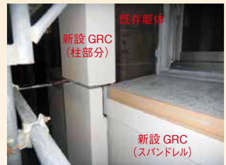
新設 GRC 取付け状況 (1)
