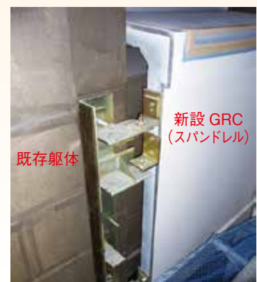
新設 GRC 取付け状況 (2)
