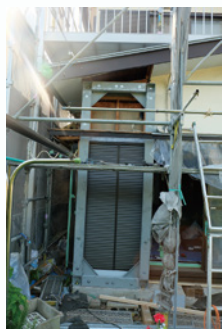
フレーム取付
