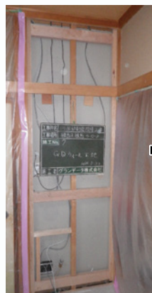
合板受材施工
