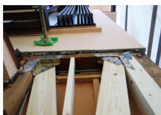
通し柱補強（室外より）
