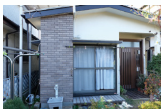
フレーム完成
