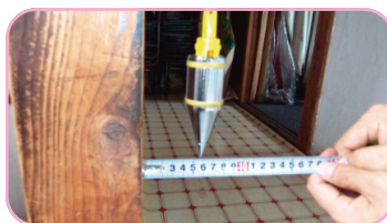
下げ振りで柱の傾きを調査
