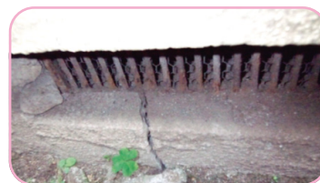
基礎のひび割れを調査
