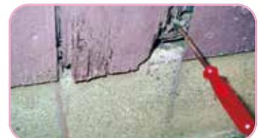
土台の腐朽度合いを調査
