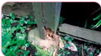
柱脚の腐朽を調査
