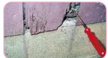
土台の腐朽度合いを調査
