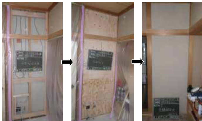
合板受材施工
