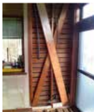
食堂内既存壁補強状況
