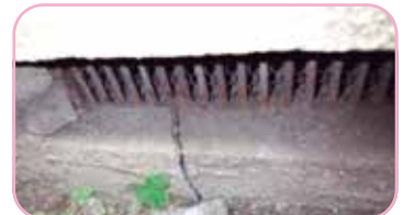
基礎のひび割れを調査
