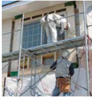
2階の開口部補強
