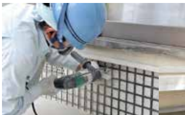
FRPグリッド設置
