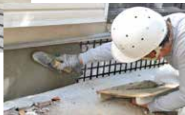
ERモルタル塗り込み
