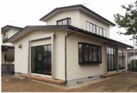
フレームプラス施工事例
