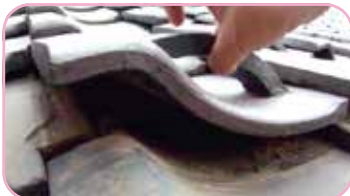
屋根瓦の葺き土の有無を調査
