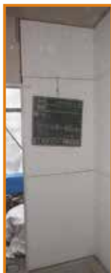
③パネルの施工
