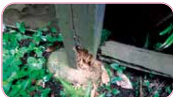
柱脚の腐朽を調査
