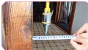
下げ振りで柱の傾きを調査
