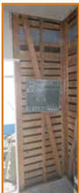
①既存壁の撤去
