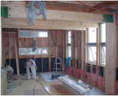
間仕切部の耐震補強
