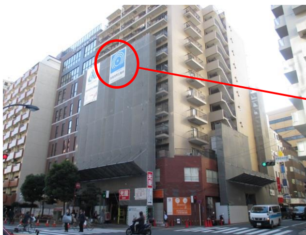
工事現場掲示風景
