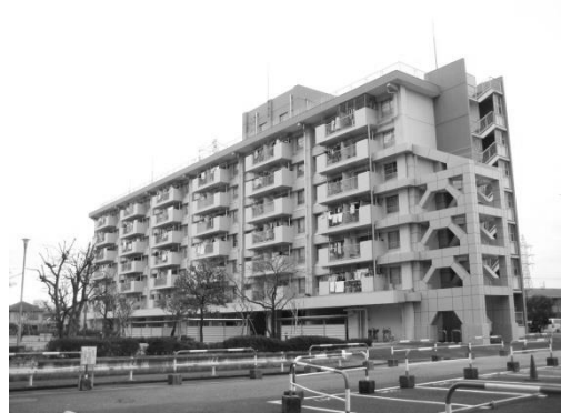
耐震改修事例 東京都住宅供給公社宇喜田第二住宅
