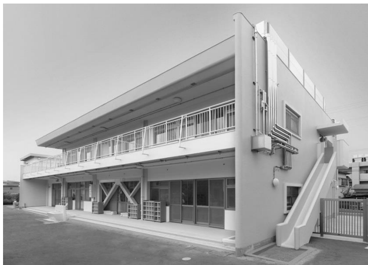
保育所の耐震改修事例
