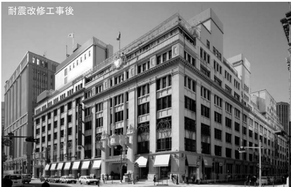
写真 要緊急安全確認大規模建築物(百貨店)の耐震改修事例 (平成 20 年 5 月改修工事完了)
